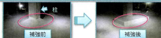
水を貯める池にある柱の根元部分にコンクリートを増し打ちし、柱の耐震強度を高めています。
