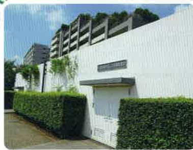
桃井第二災害備蓄倉庫
