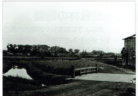
昭和29年当時の善福寺川西田端橋付近(荻窪1・3丁目)
