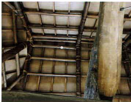
▲屋根（写真は屋根の裏側）：建物の一部部材を再利用するなど、古民家の空間を再現しています。
