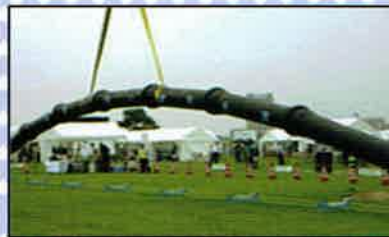
▲耐震継手管を吊り上げた様子
