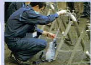
▲仮設の蛇口による応急給水
