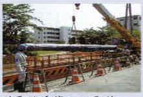
耐震継手管への取替
